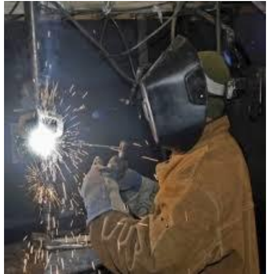
Gambar 8.15 Posisi Pengelasan Vertikal
