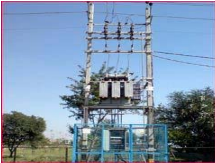
Gambar 1.3 Trafo Distribusi Tenaga Listrik
