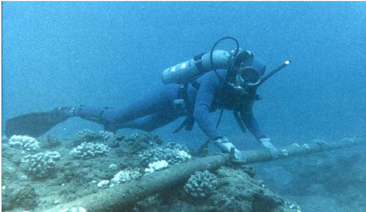
Gambar 1.9 Saluran Transmisi Bawa Laut
